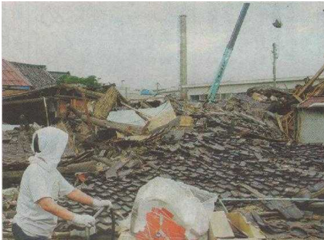
新潟県中越沖地震で全壊した原酒造の土蔵 = 7月15日、新潟県柏崎市で
